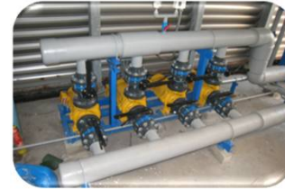
ระบบ Ozone สำหรับ Cooling Tower ศูนย์การค้าเอสพลานาด รัชดาภิเษก
