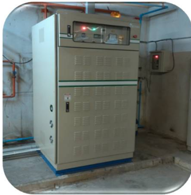
ระบบ Ozone สำหรับ Cooling Tower ศูนย์การค้าเอสพลานาด รัชดาภิเษก
